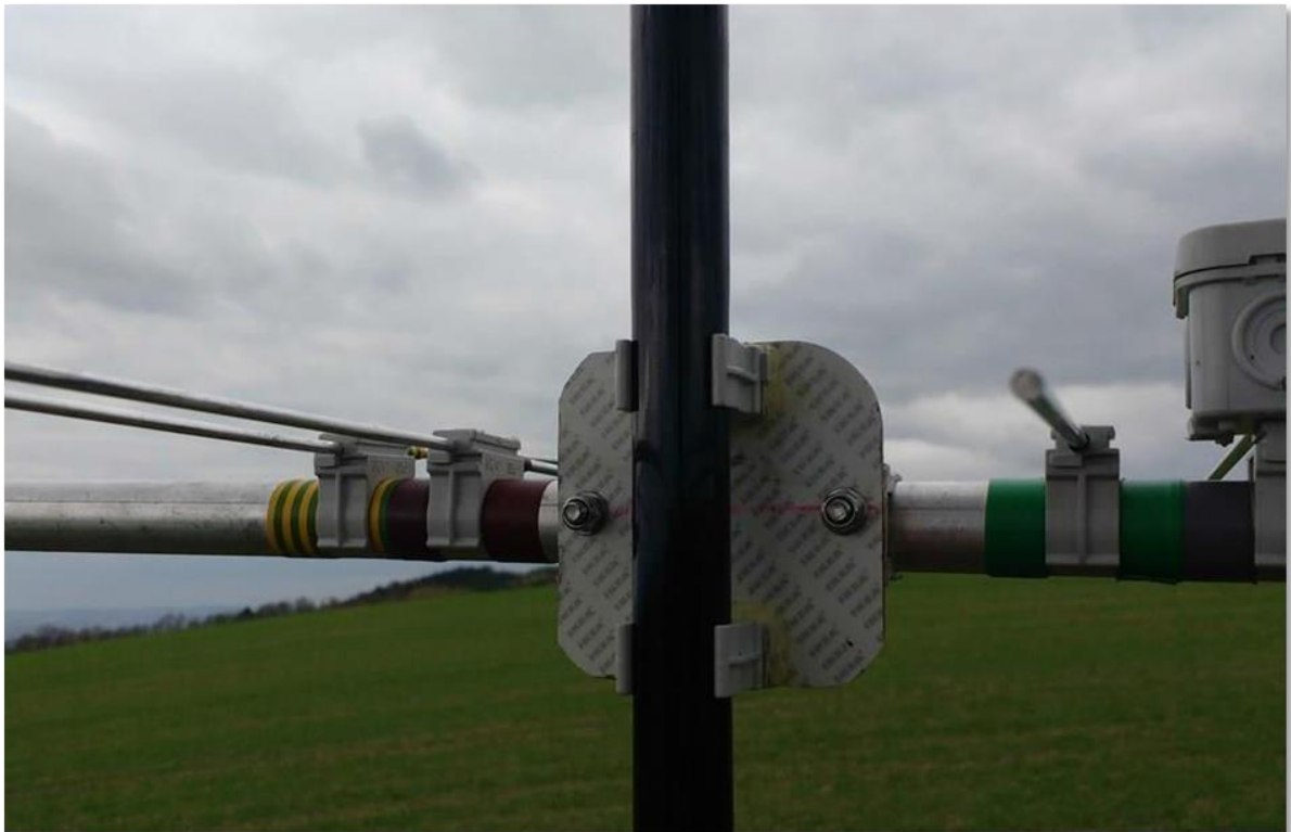
Details der Schellen für die einzelnen Elemente und der Antennenbefestigung am Mast.
