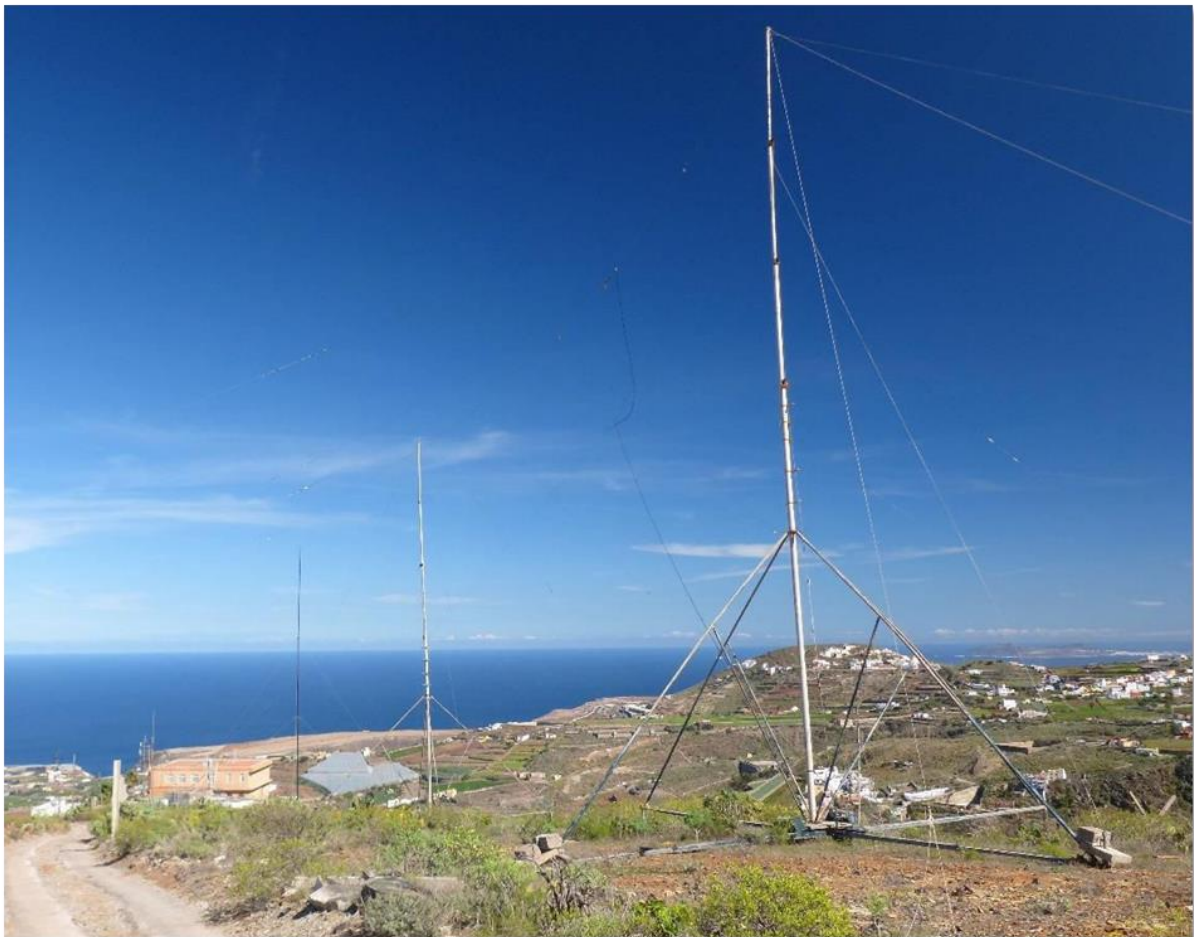
Das ist der 5 Element Beam für 7Mhz in Richtung Europa / Japan in ca. 20m Höhe.
