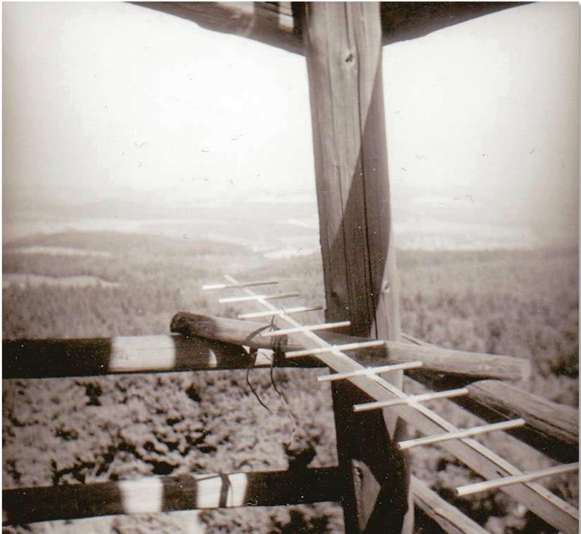
Die 20 Elemente Yagi Richtung Berlin auf dem Holzturm.
