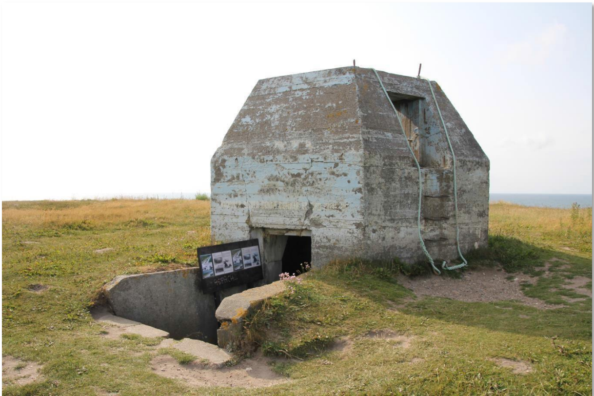
Bunker und Fundament Radar
