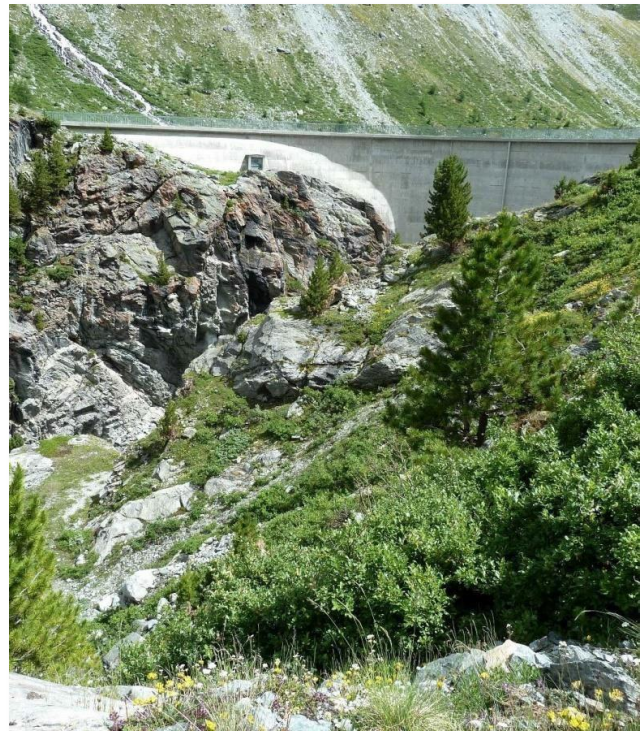
Die Staumauer am Turtmannsee
